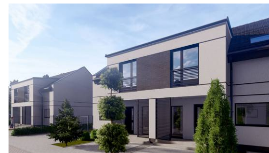
WIDOK OD STRONY ULICY
